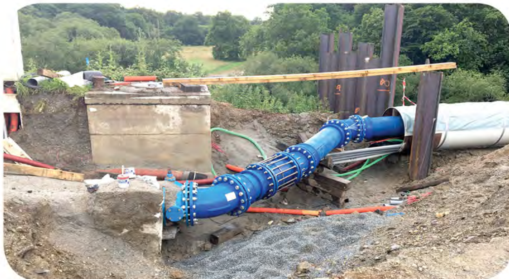
dévoiement des réseaux- Lac au Duc à Ploërmel
