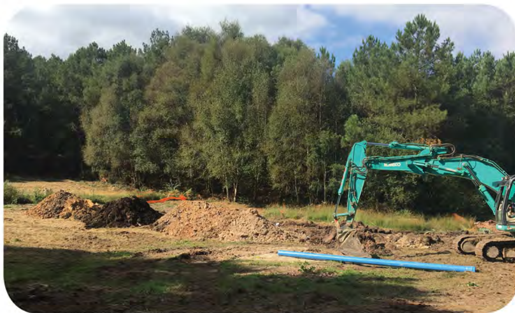
renouvellement des conduites d'eau brute- Lambrun à Concoret
