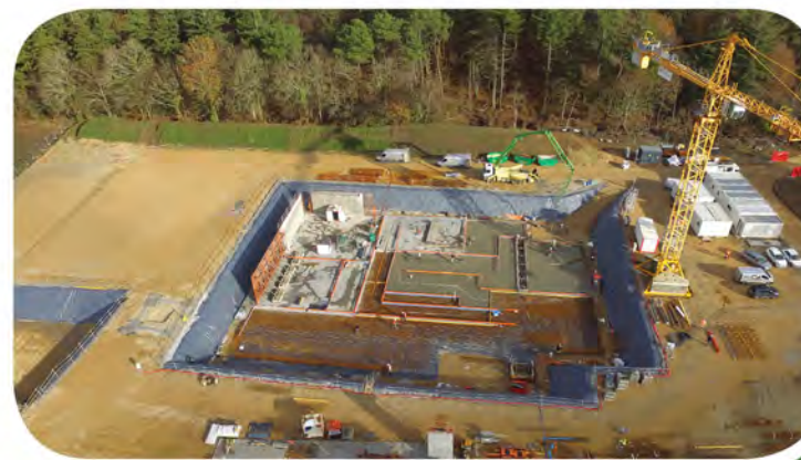
Radier du bâtiment traitement des eaux, en cours de coulage
