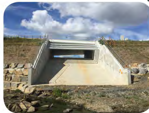
vue en aval du barrage
