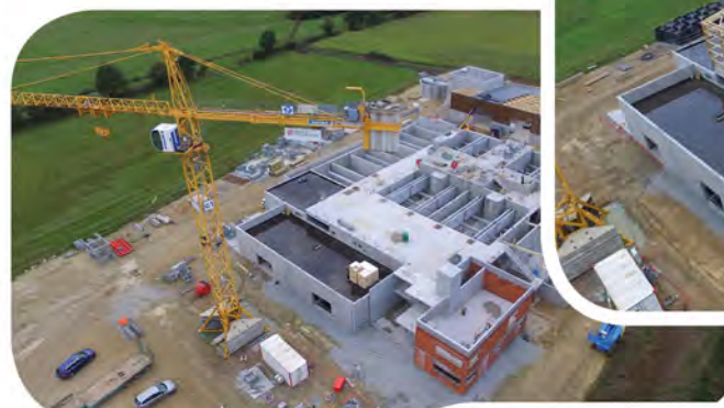
coulage de la dernière dalle
