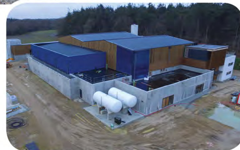
bardage en cours et pose du polycarbonate
