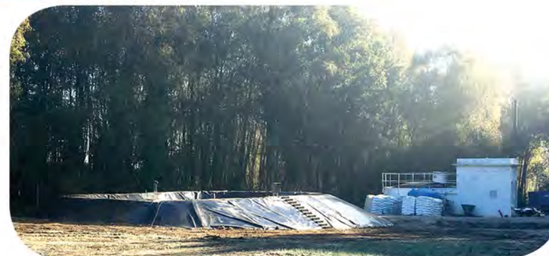
lagune de décantation Ker Anna- Séglien
