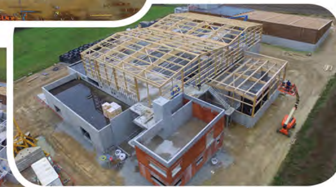
montage de la charpente
