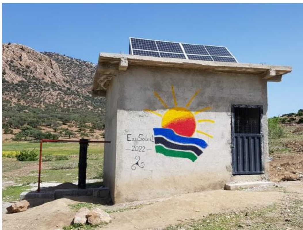
Modules solaires sur le local technique avec à gauche la tête de forage et la tuyauterie de refoulement de la pompe – village d'Amarouch
